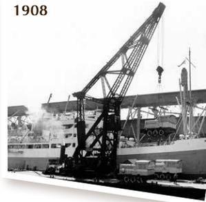
En 1908, cette grue flottante devient la plus puissante du port avec une capacité de 75 tonnes. La plupart des équipements mécanisés sont alors la propriété des autorités du port qui les louent aux compagnies de débardage.
